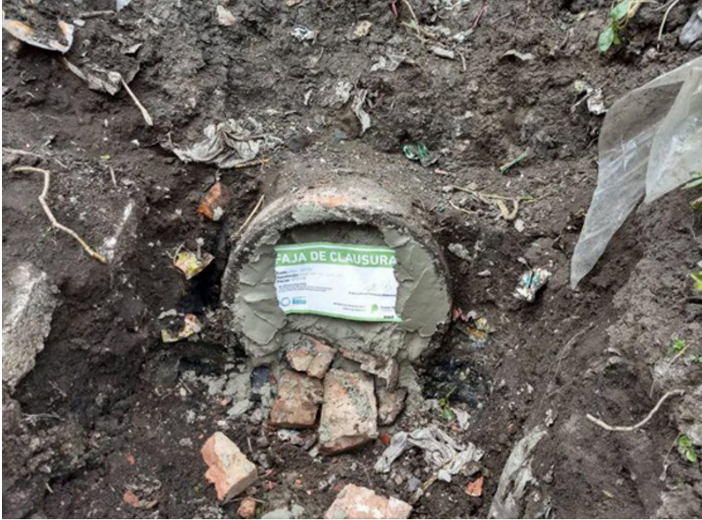
Figura 6. Clausura a cargo de la OPDS de caño por el cual se vertían desechos fabriles al arroyo Las Piedras.
